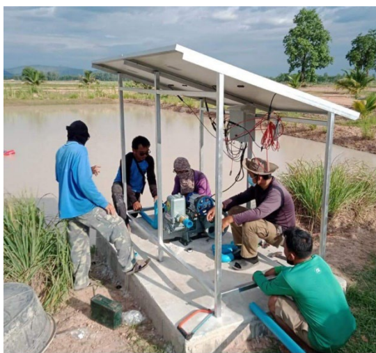
ภาพที่ 5 ระบบสูบน้ำพลังงานแสงอาทิตย์สำหรับบ่อน้ำเกษตรพอเพียง
